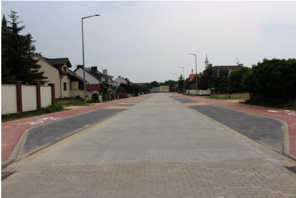
Ukończona budowa ul. Leopolda Staffa
