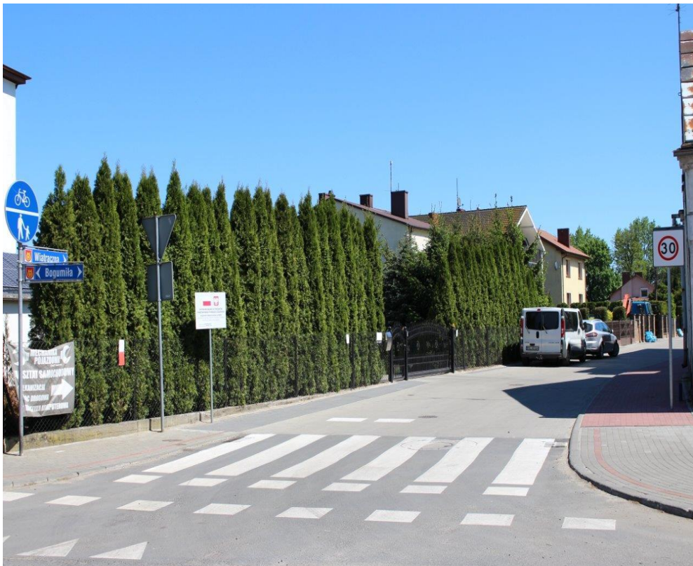
Ukończona budowa ul. Wiatracznej
