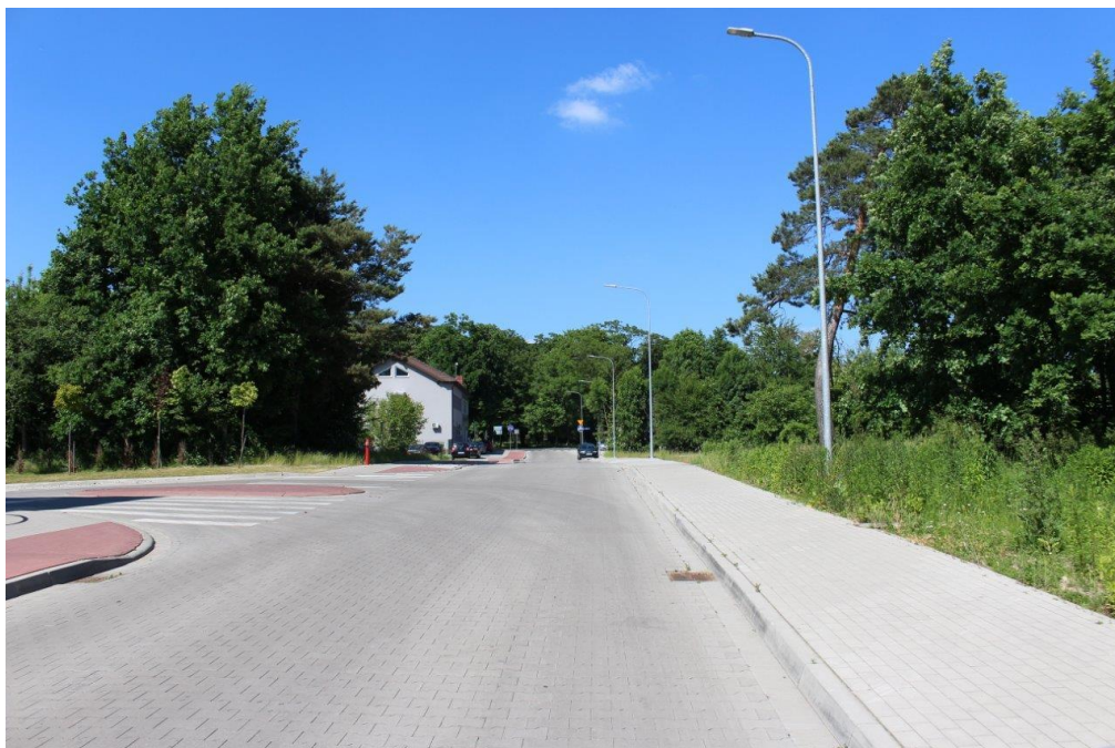
Ukończona budowa ul. Wisławy Szymborskiej
