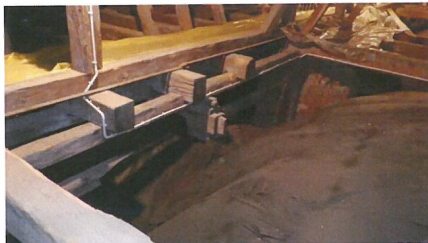
Fot.21) Węzeł W-6/P do W-11/P – dodatkowe klinowanie ugiętych belek podwalinowych na zębrze sklepienia pomiędzy filarami nośnymi.
