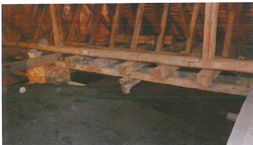
Fot.20) Węzeł W-6/L do W-11/L – dodatkowe klinowanie ugiętych belek podwalinowych na zębrze sklepienia pomiędzy filarami nośnymi.
