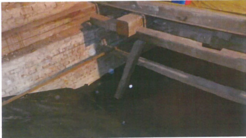
Fot.4) Węzeł W-1/P – podparcie stemplem o sklepienie ugiętej belki podwalinowej.
