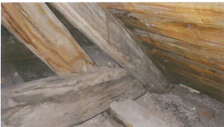
Fot. 14) Węzeł W-19/P – skrzyżowana belka tramowa i krokiew.
